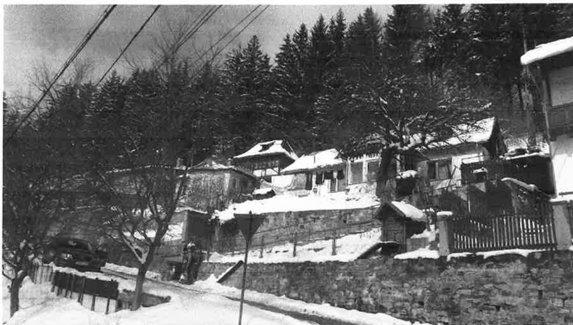
Str. Baiului – consolidări în trepte în zona capătului de est
