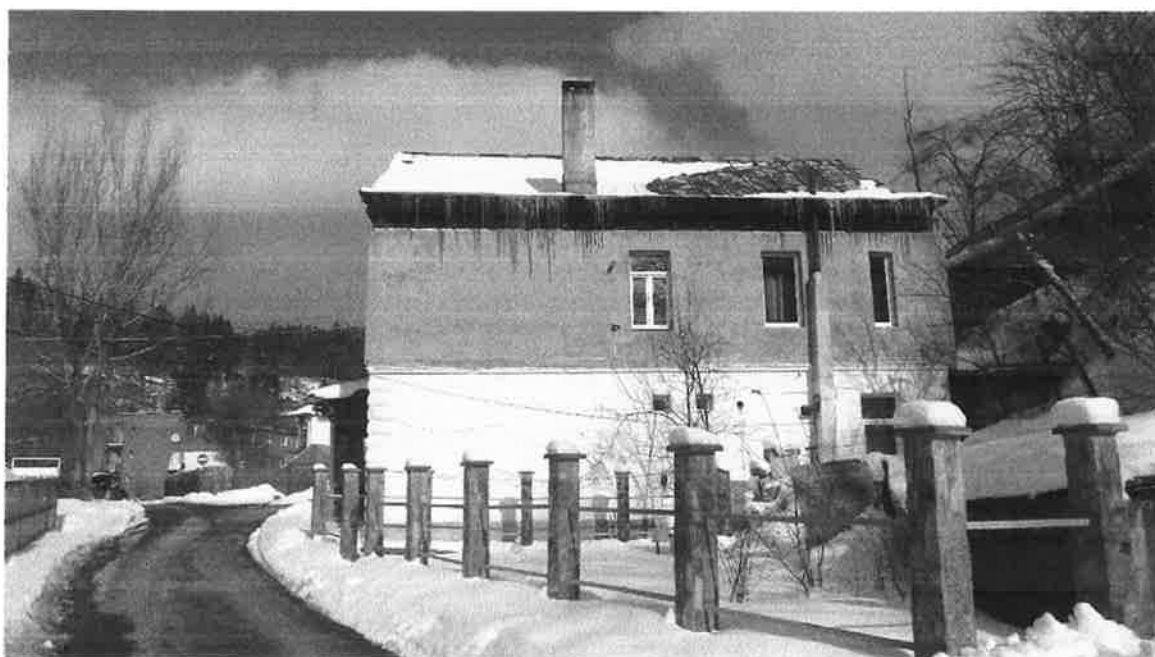
Băile fabricii de postav în martie 2022
