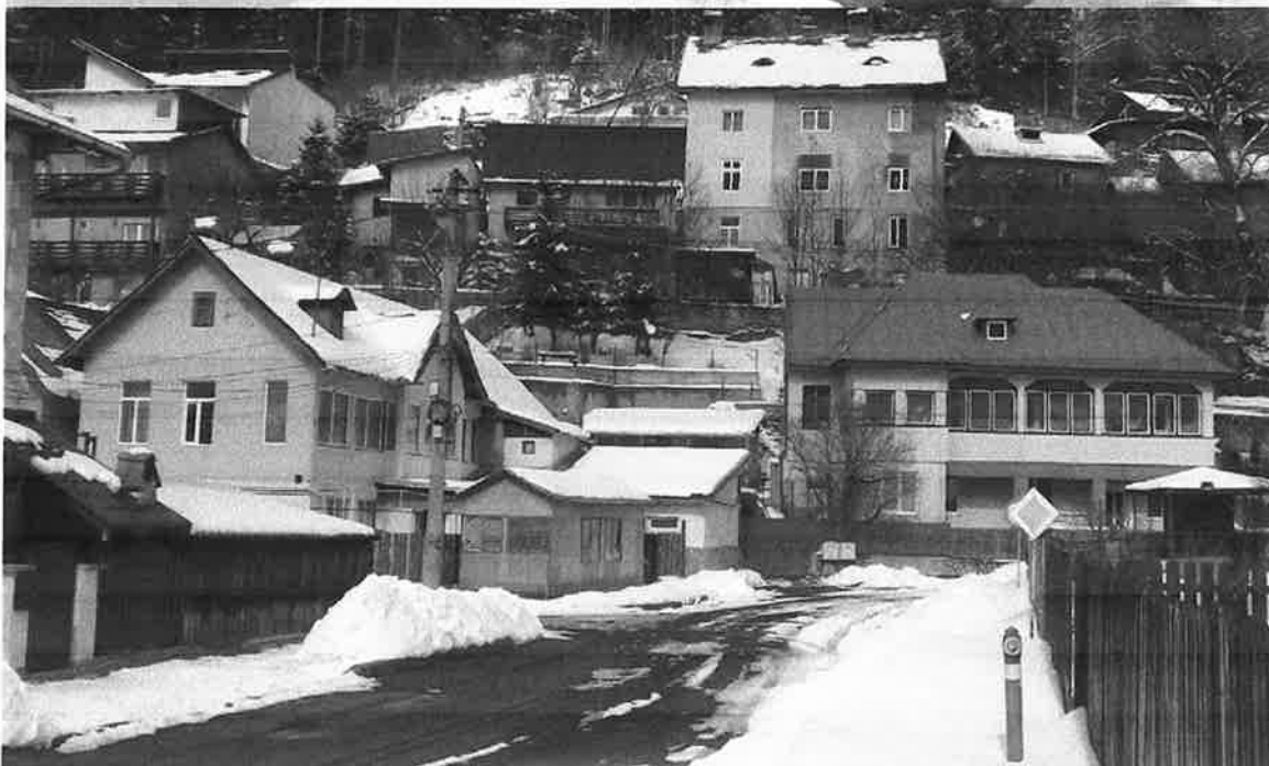
Un frumos exemplu de restaurare pe str. 24 Ianuarie, la nr. 2, și exemple nu la fel de fericite peste drum de ea, la nr. 13, 15, 17 și 19. În fundal, construcții de pe str. Parcului.
