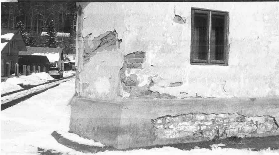
Str. Vânători, nr. 2 – starea de conservare îngăduie să se observe detaliat tehnica de construcție mixtă
