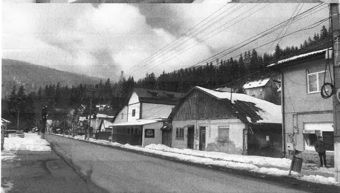
Construcții din prima etapă de dezvoltare pe str. Independenței, nr.21, 23, 41 , supraviețuind printre intruziuni moderne
