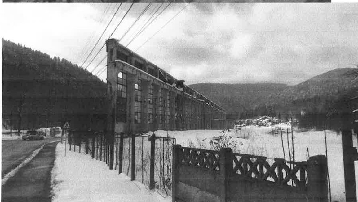
Demolarea fabricii în 2020 (după Frîncu 2020c) și ruinele ei în martie 2022
